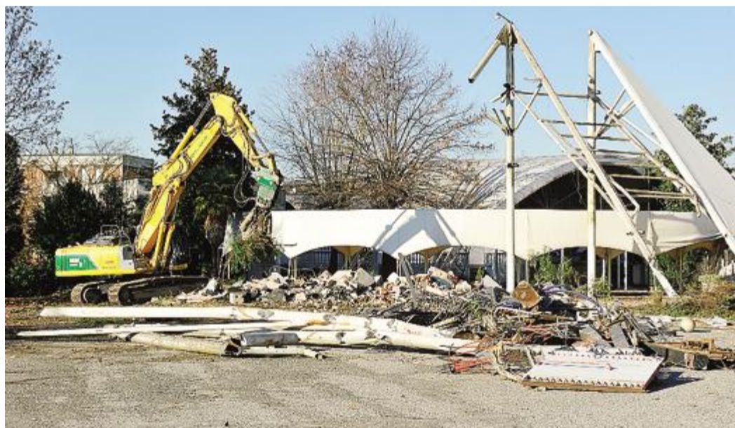
Un momento della demolizione della ex sala da ballo. Le ruspe sono entrate in azione e lavorano a pieno ritmo
